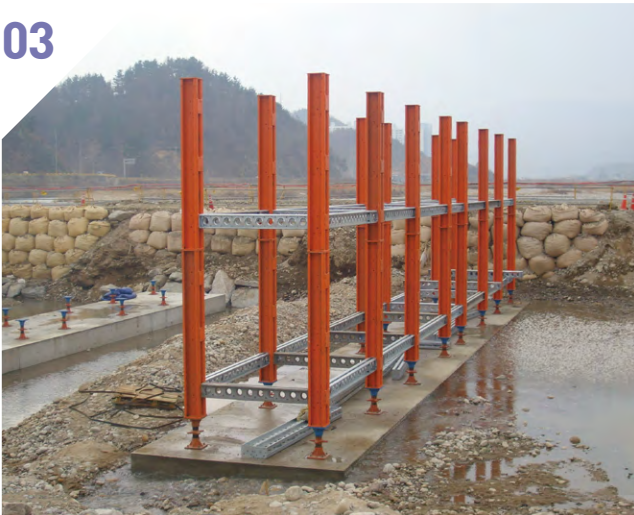
3. 수직재 및 수평재 설치
