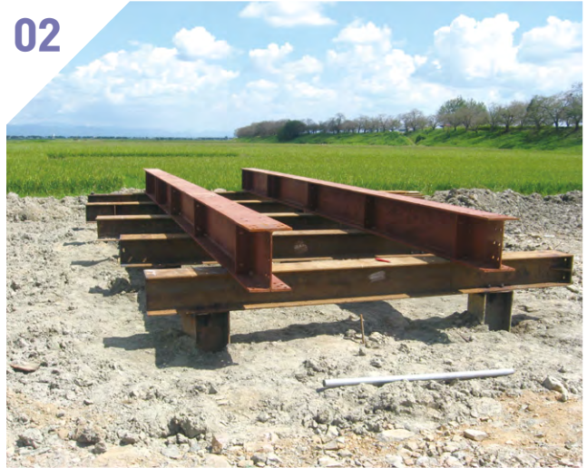
2. 바닥재 및 가로보 설치
