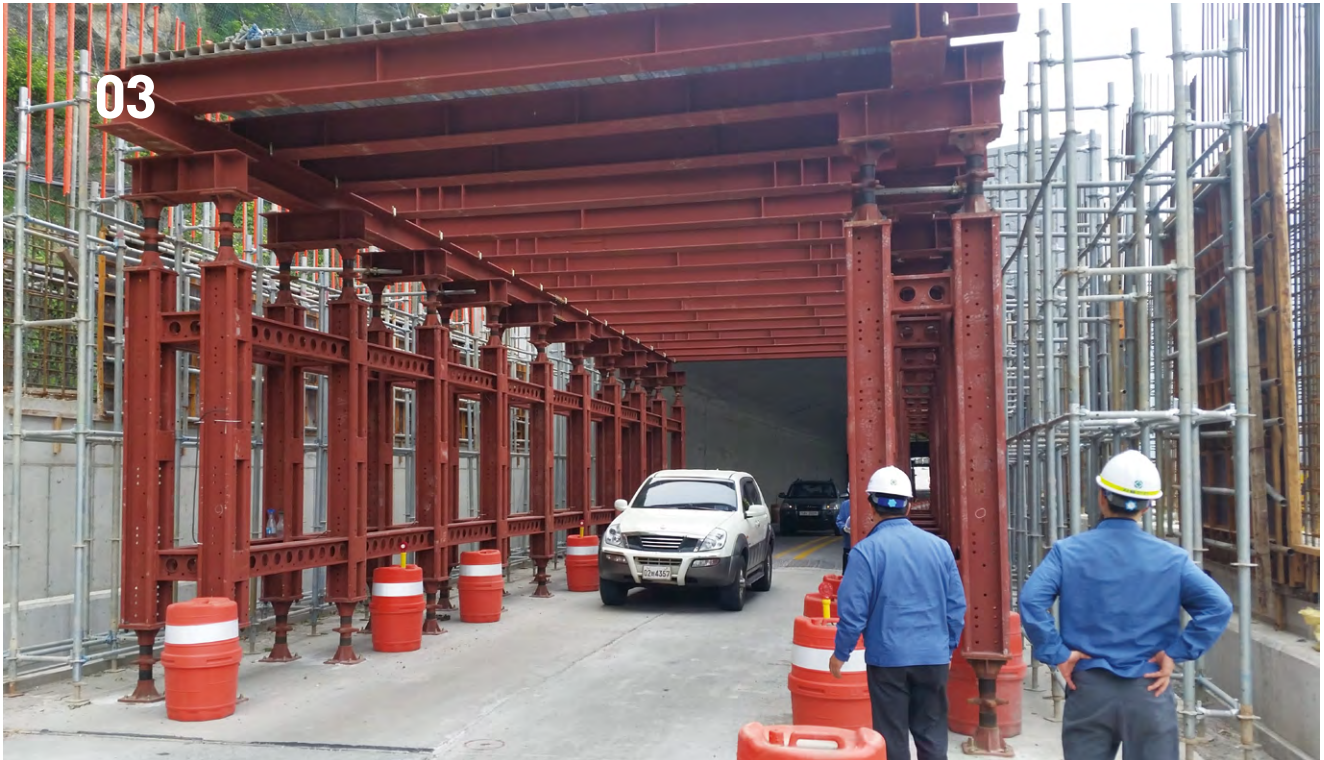
03 — ◇ 공사 명 : 정선 피암터널 ◇ 발 주 처 : 강원도 ◇ 원 청 사 : 신한종합건설
