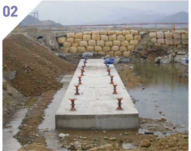
2. 세트앙카 및 스크류잭 설치
