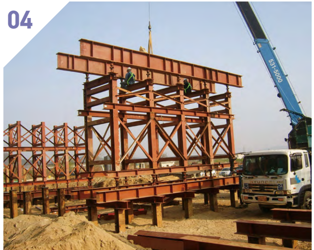
4. 헤더 및 세컨드리 설치
