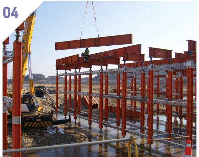
4. 헤더 및 세컨드리 설치
