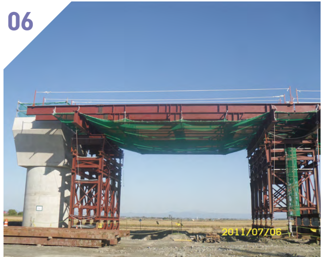
6. 동바리 시공 완료
