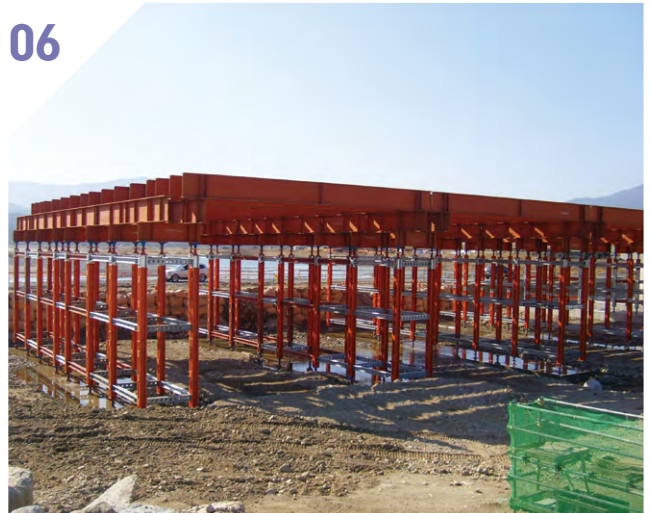
6. 동바리 시공 완료
