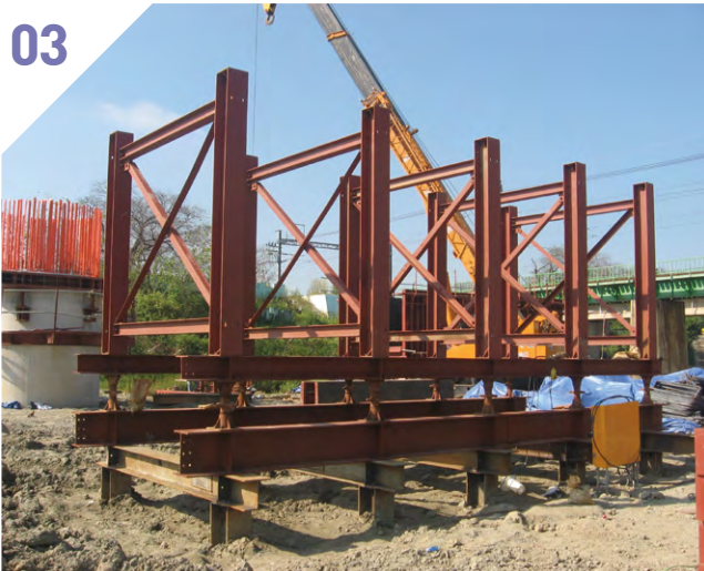
3. 수직재 및 수평재 설치
