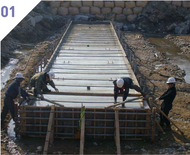
1. 부지 정비 및 기초 시공
